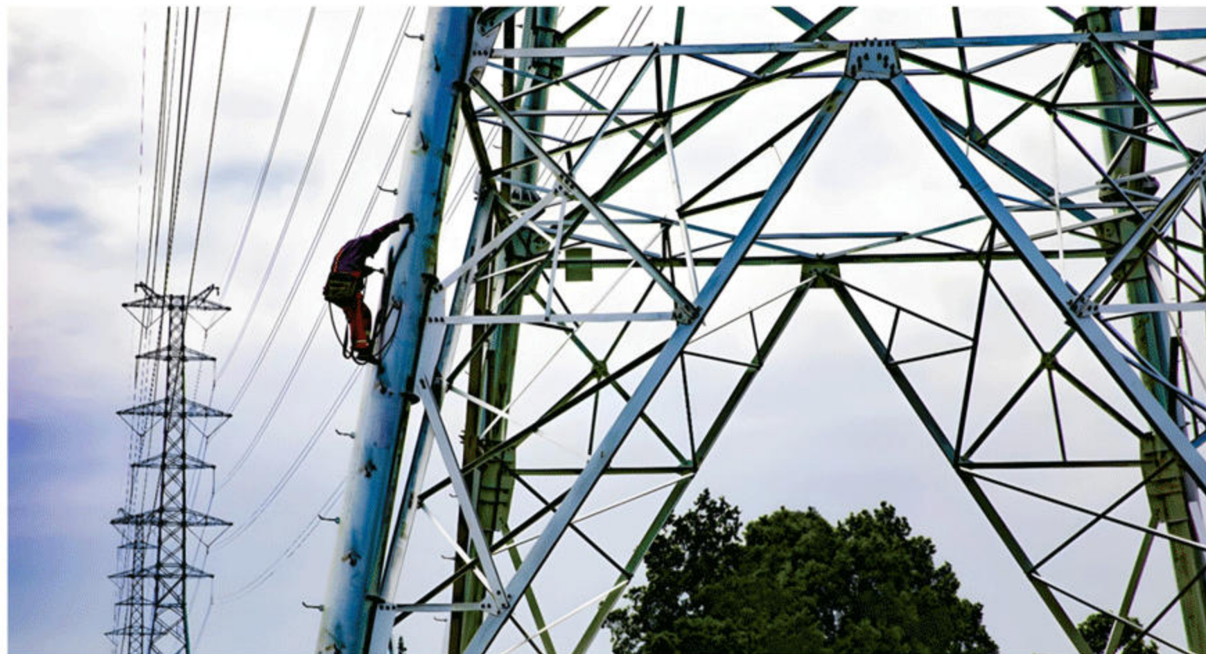
国网成都供电公司电网建设人员登塔勘察
