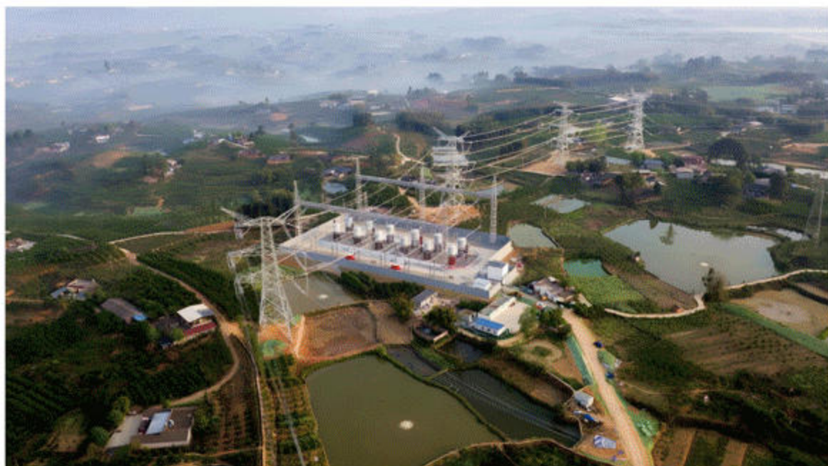
尖山-彭祖500千伏线路加装串抗工程
